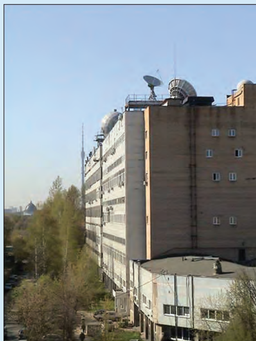
Здание НЦ ОМЗ
