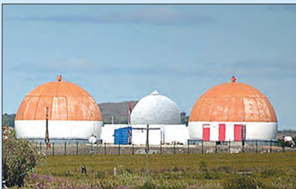
Типовые сооружения для размещения аппаратуры ИП
