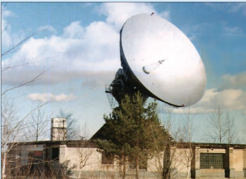
Командно-измерительная система Ки-диапазона (КИП14) Обеспечивает работу КА «Глонасс», «Молния», «Гейзер». Год разработки – 1970
