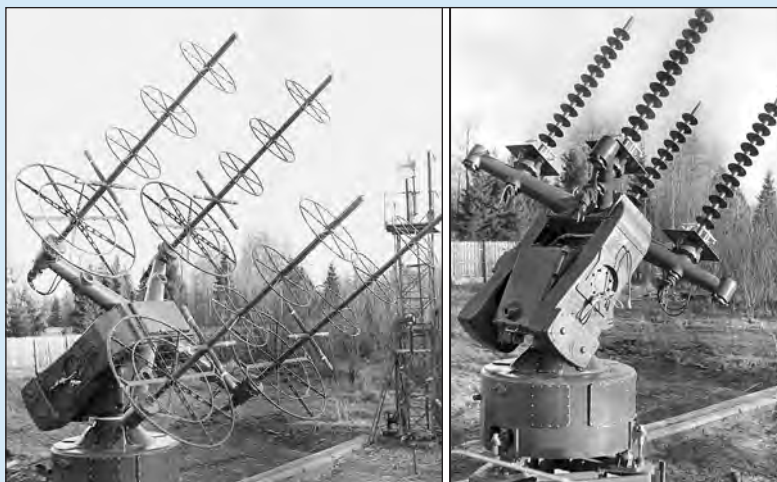
Телеметрические антенны метрового (слева) и дециметрового (справа) диапазонов (1965, 1966 гг.)
