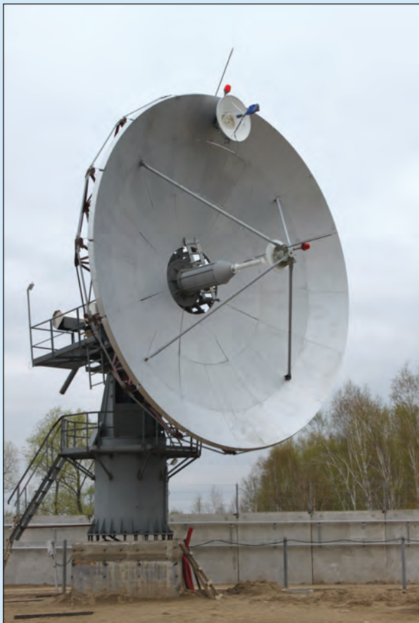
Полноповоротная 9-ти метровая антенна приемного комплекса ПК-9 в Сибирском РЦ
