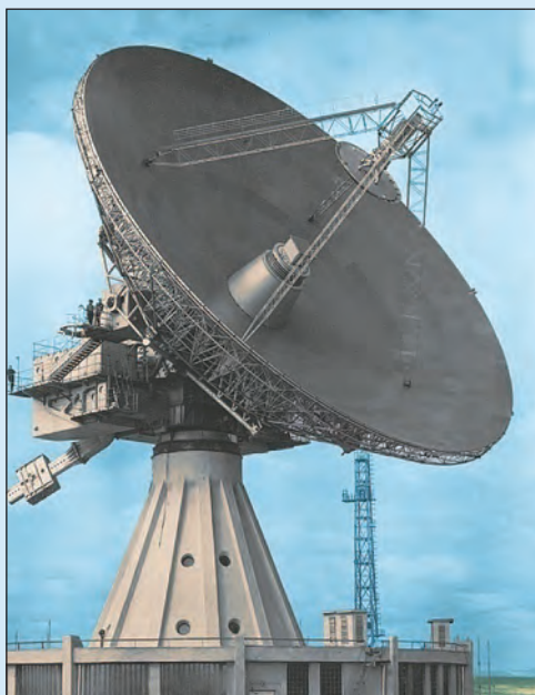
Антенна П-400П для управления межпланетными КА. Диаметр 32 м (1973 г.)
