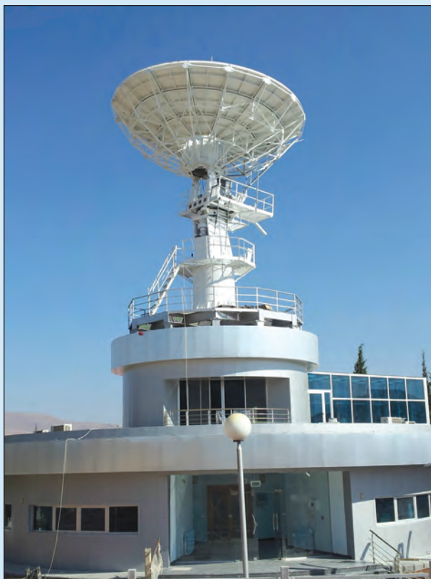
Техническое здание комплекса ПК-9 с 9-ти метровой антенной на территории зарубежного заказчика
