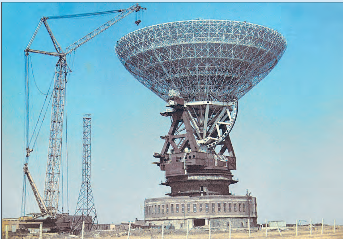
Антенна П-2500 в процессе монтажа (1975 г.)
